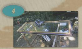
Die neue Isolierverglasung wird mit profilierten Glasleisten gehalten, unten wird eine neue Wassernase angebracht.
