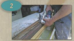
Der Glasfalz wird tiefer und breiter gefräst, an der Festverglasung...
